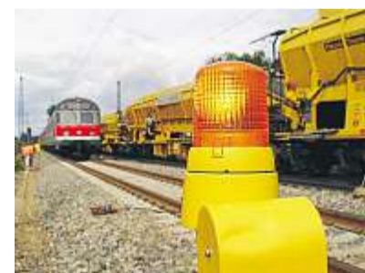
Während der Umbauarbeiten läuft der Zugverkehr eingleisig weiter.
