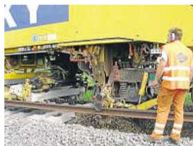
Nachdem der Schotter eingefüllt ist, werden sofort neue Schwellen gelegt.
